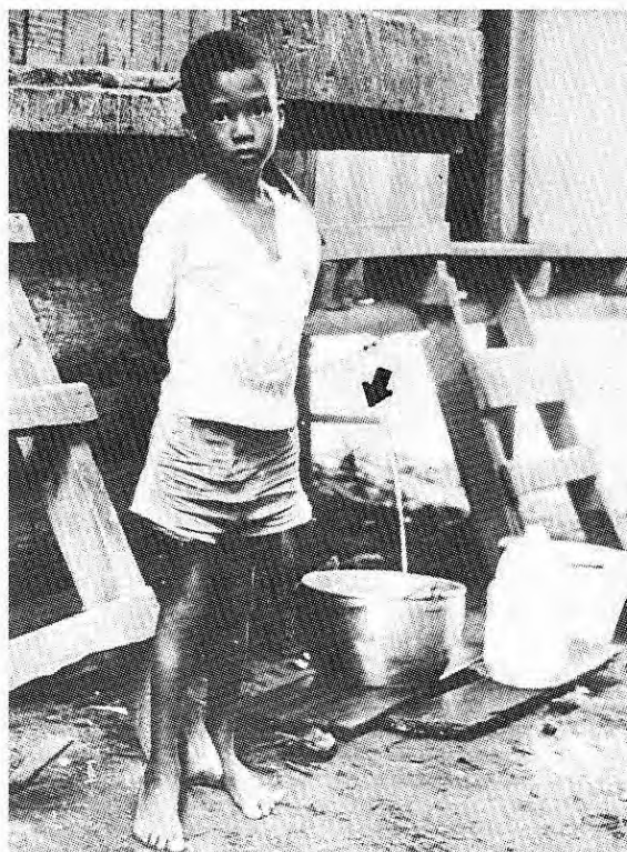
Figura 5. En Salahonda el acueducto local no envía el agua con la presión suficiente a las viviendas y muy pocos sectores cuentan con tubos elevados, como en este caso.
