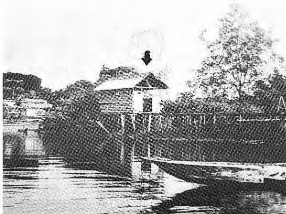
Figura 4. Letrina pública en Salahonda, Nariño. Las heces caían directamente al agua del caño. El tubo madre que conduce el agua del acueducto local cruza este caño y es frecuente que las hélices de los botes lo rompan contaminando el agua de consumo humano.
